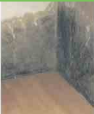
Defekte Horizontalsperre
