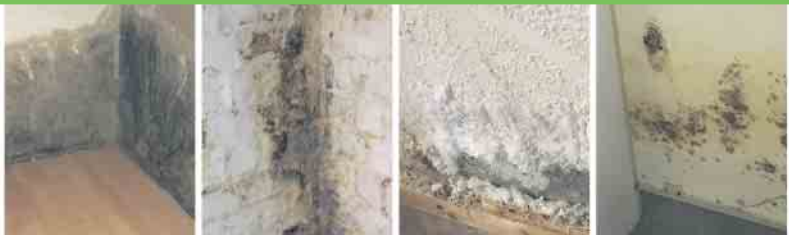
Defekte Horizontalsperre Querdurchfeuchtung Ausblühungen Schimmelbefall
