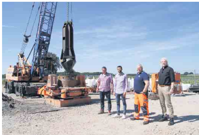
Stefan Heimberg, Geschäftsführer Plängskens Brunnenbau GmbH Robin Schmidt, Betriebsleiter Versorgungs- und Verkehrsbetrieb Leo Venten, Wassermeister Versorgungs- und Verkehrsbetrieb Ralf Börger, verantwortlicher Projektleiter Brunnenbau Gelsenwasser AG. Foto: Stadt Straelen
