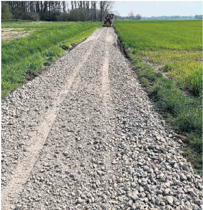
Die Arbeiten am Radweg gehen voran. Bildrechte: Stadt Straelen
