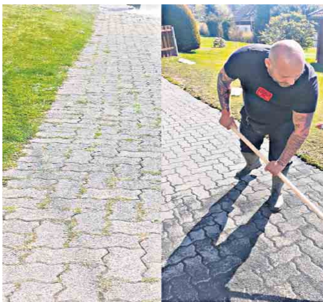
Reinigung von Fugen vorher und nachher.
