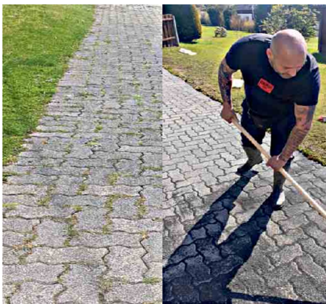
Reinigung von Fugen vorher und nachher.
