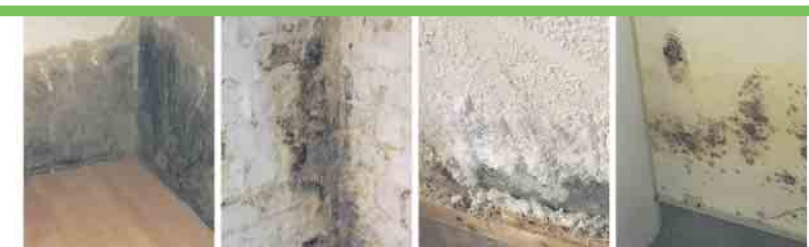
Defekte Horizontalsperre Querdurchfeuchtung Ausblühungen Schimmelbefall
