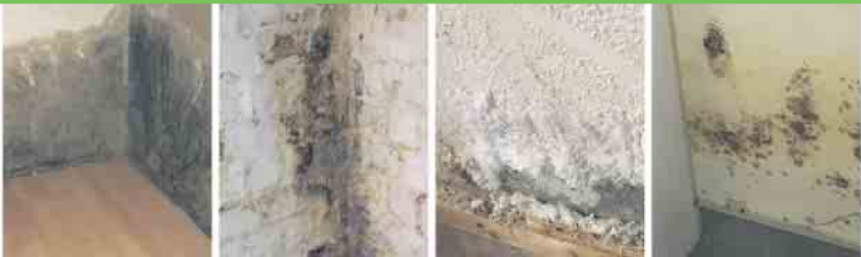
Defekte Horizontalsperre Querdurchfeuchtung Ausblühungen Schimmelbefall
