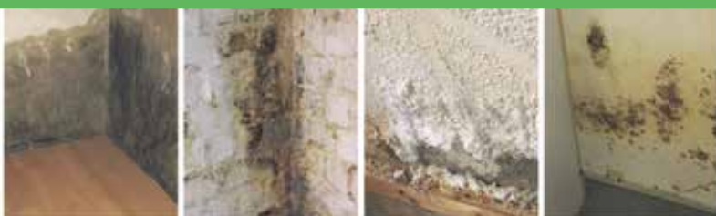
Defekte Horizontalsperre
