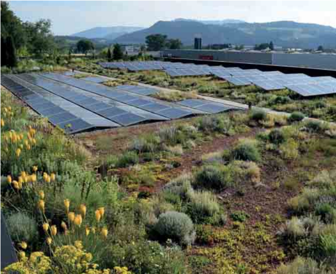
Die perfekte Kombi: Photovoltaik und Gründach. Foto: Bundesverband GebäudeGrün e.V./akz-o
