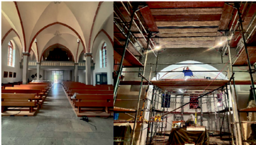
Bilder aus der Bauphase – co Silke Herchenbach
