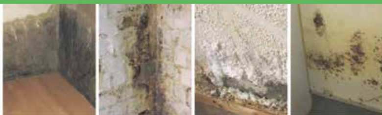
Defekte Horizontalsperre
