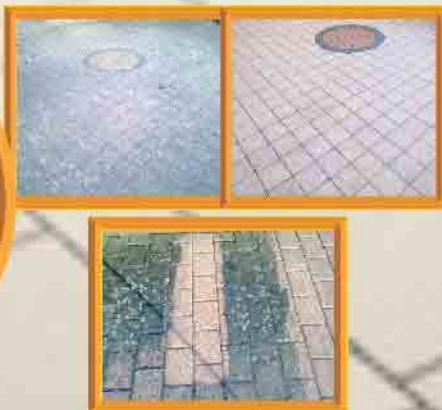
**Wir arbeiten mit einem Hochdruckreiniger
