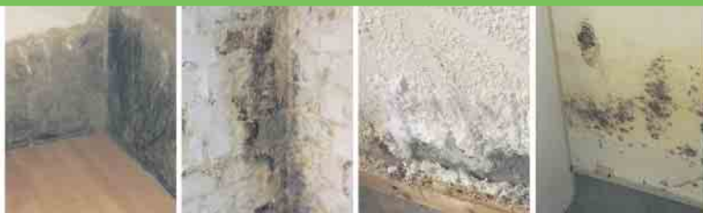
Defekte Horizontalsperre
