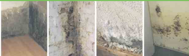
Defekte Horizontalsperre Querdurchfeuchtung Ausblühungen Schimmelbefall
