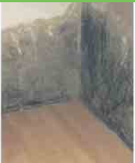
Defekte Horizontalsperre
