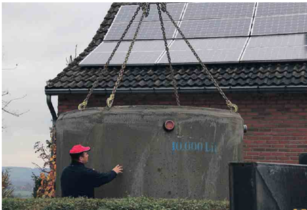
Aufgrund der immer länger anhaltenden Trockenperioden sollten die Regenwasserzisternen ausreichend groß geplant werden. Foto: Intewa/akz-o
