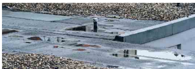
Ein Flachdach wie dieses mit stehendem Wasser und Rissen in den Dachbahnen sollte dringend saniert werden.
