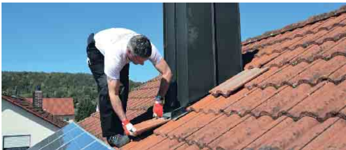
Anschlüsse an Dachdurchdringungen werden beim DachCheck begutachtet. Foto: HF Redaktion/akz—o
