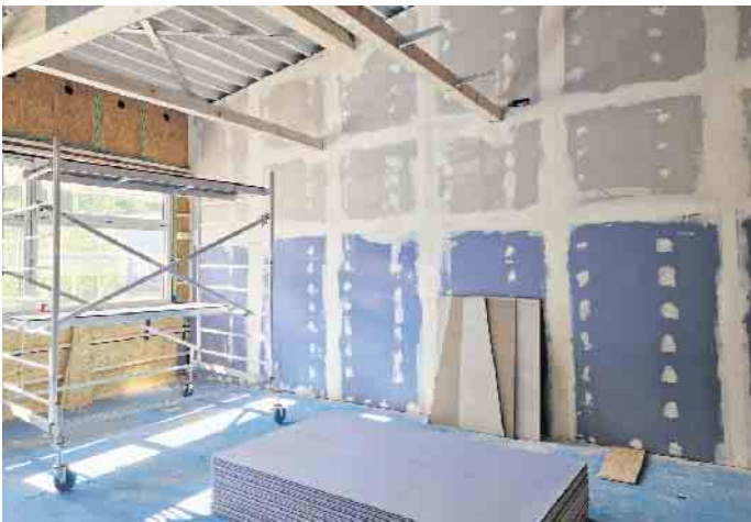
In den künftigen Klassenräumen läuft der Innenausbau. Die Wände werden mit Rigipsplatten verkleidet und anschließend verspachtelt.
