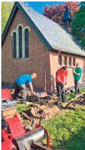
Tiefbauarbeiten zur Verlegung von Strom und Wasser
