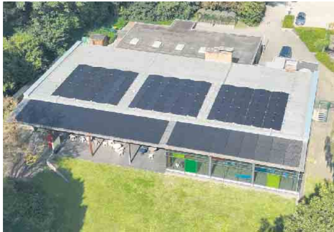
Photovoltaik auf dem Hallenbaddach
