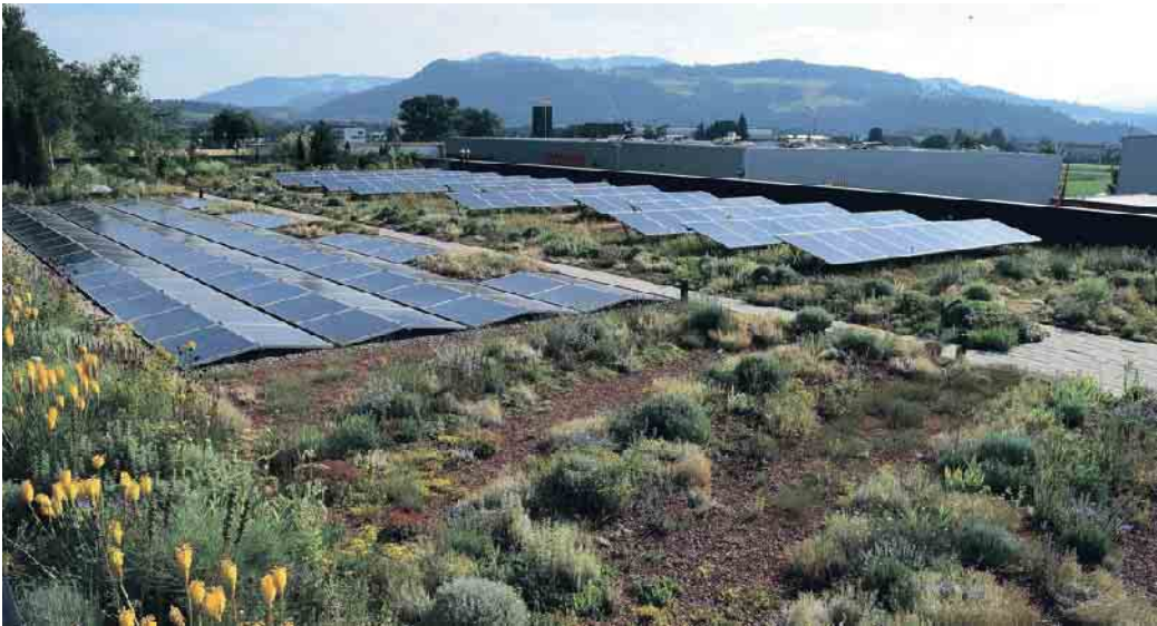
Die perfekte Kombi: Photovoltaik und Gründach. Foto: Bundesverband GebäudeGrün e.V./akz-o
