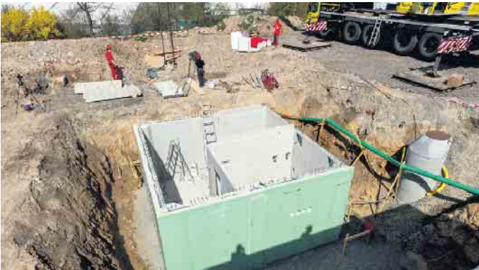
6,50 mal 6,50 Meter Baugrube reichen für einen kompakten Teilkeller meist schon aus. Foto: GÜF/Glatthaar Keller
