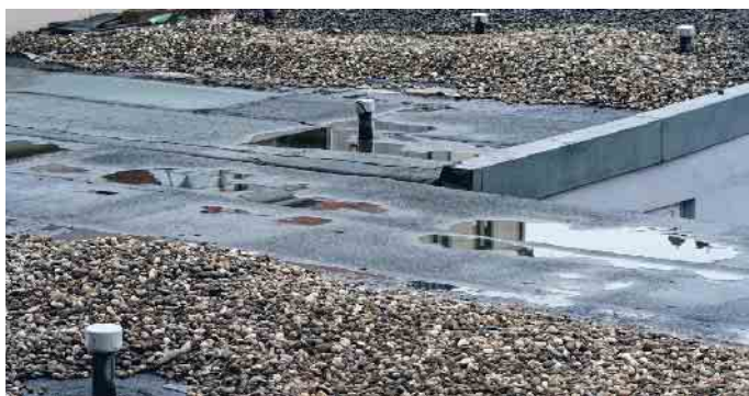
Ein Flachdach wie dieses mit stehendem Wasser und Rissen in den Dachbahnen sollte dringend saniert werden. Foto: Datenschutz-Stockfoto/shutterstock/Triflex/akz-o
