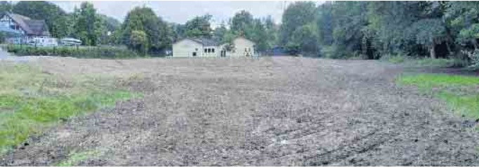
Rund 3.500 m³ Retentionsraum dienen dem Hochwasserschutz
