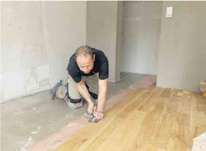
Ein Profi klebt die Eichendielen vollflächig auf den Untergrund. Das sichert eine gute Wärmeübertragung durch die Fußbodenheizung und sorgt für einen niedrigen Trittschall. Der eingesetzte Klebstoff trägt das Ecode-Zeichen EC 1. Dieses Siegel gewährleistet geringste Emissionen und schützt die Gesundheit der Verarbeiter und Bewohner. Foto: Initiative Parkett im Klebeverbund (PIK)
