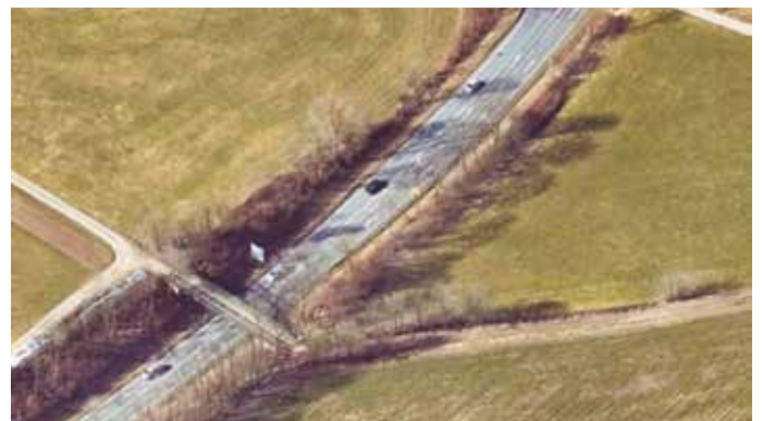
Die Brücke bei Buchen wird erneuert.
