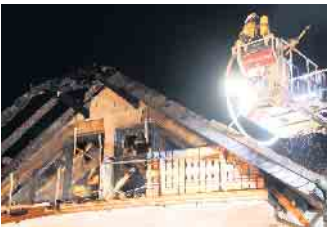
Feuerwehrleute öffnen die Dachhaut, um Glutnester abzulöschen.
