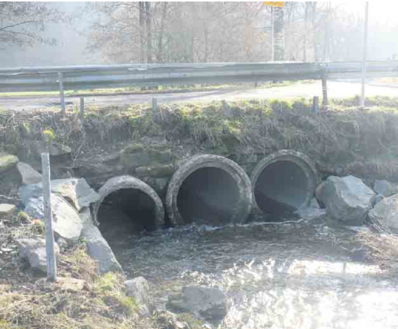
Bei großen Regenereignissen wurden regelmäßig angrenzende Wiesen überflutet. Die Brücke erhält nun einen größeren Querschnitt.
