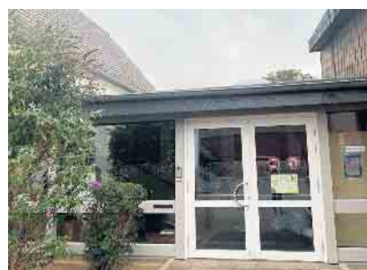
Eingangsbereich Regenbogenschule Standort Kelz
