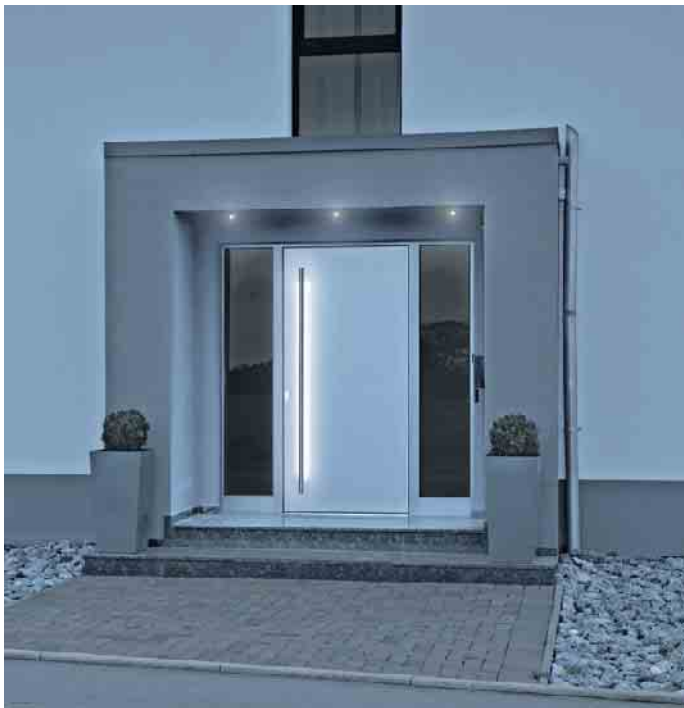
Hautür mit raffinierter LED-Beleuchtung. Foto: VFF/RODENBERG Türsysteme
