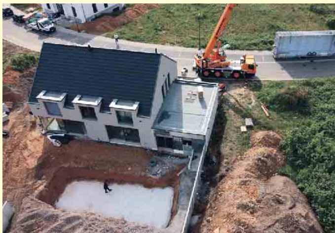
Per Kran wird das Becken eingesetzt. Foto: Vogel Pool/akz-o
