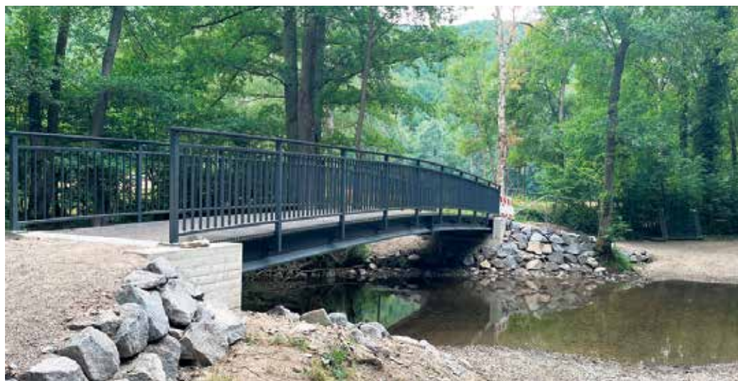
Brücke oberhalb Renker
