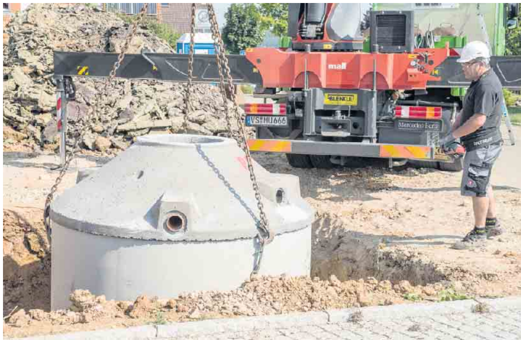
Eine Betonzisterne wird per Kran in die vorbereitete Gartengrube eingelassen. Foto: DJD/Mall
