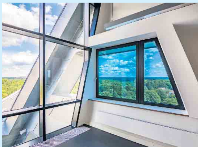
Mit Sonnenschutzgläsern lassen sich zusätzliche Kühl- und Verschattungsmaßnahmen reduzieren. Foto: EControl-Glas GmbH & Co. KG.
