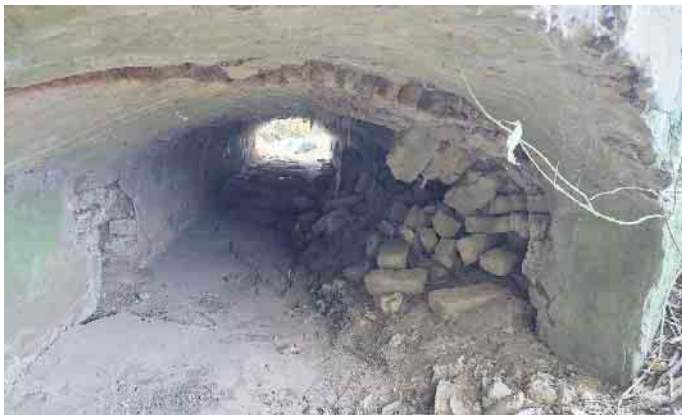
Erheblicher Schaden am Durchladdgemäuer
