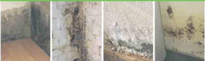
Defekte Horizontalsperre Querdurchfeuchtung Ausblühungen Schimmelbefall
