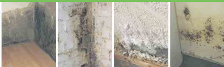
Defekte Horizontalsperre
