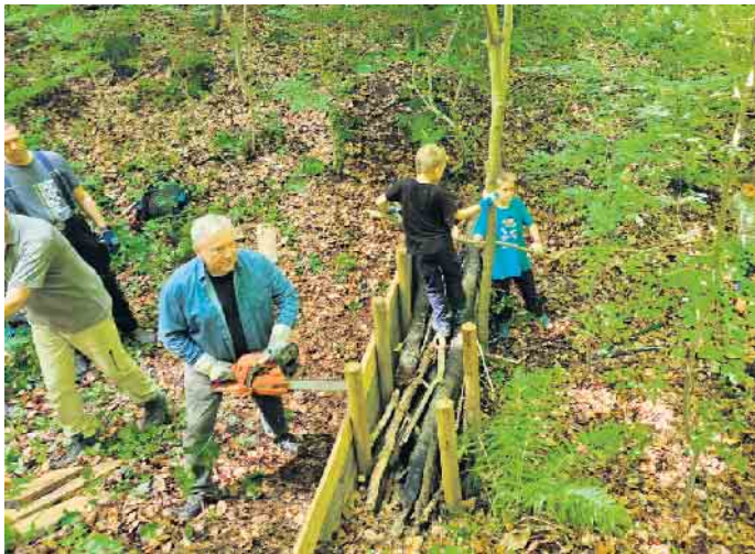
Vier solcher durchlässigen Dämme waren das Ergebnis der gelungenen Aktion, die die Hochwasserschutzinitiative Rodderfeld durchgeführt hat.
