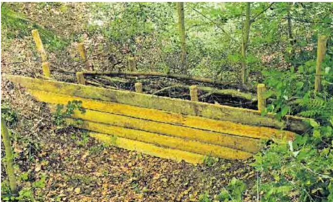
Vier solcher durchlässigen Dämme waren das Ergebnis der gelungenen Aktion, die die Hochwasserschutzinitiative Rodderfeld durchgeführt hat.
