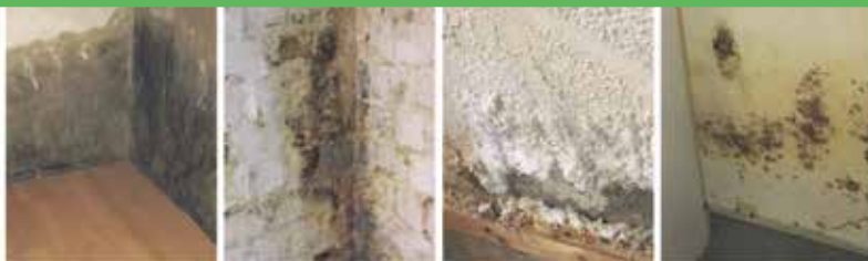
Defekte Horizontalsperre
