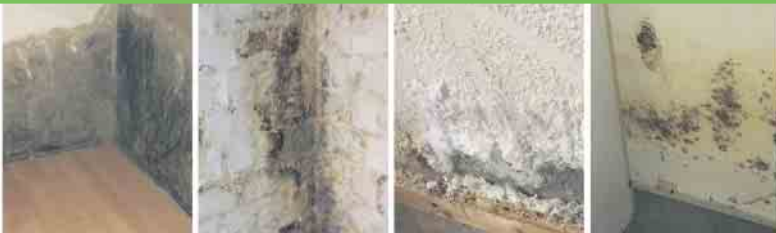
Defekte Horizontalsperre Querdurchfeuchtung Ausblühungen Schimmelbefall
