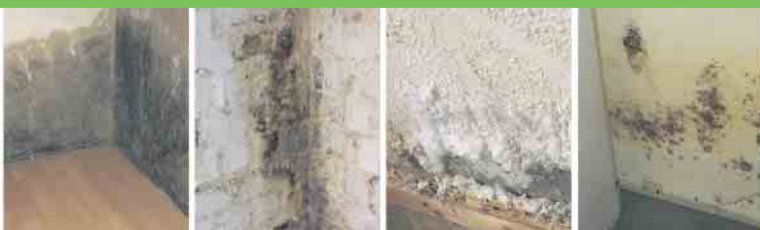
Defekte Horizontalsperre
