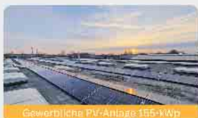
Gewerbliche PV-Anlage 155-kWp
