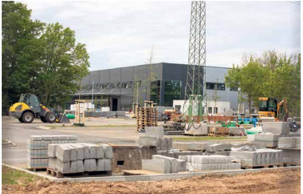
Auf dem Gelände des Autokinos baut die Firma Zeppelin Baumaschinen GmbH.
