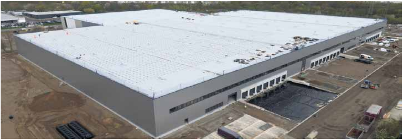
Blick von oben auf den neuen Lohistik-Standort in Porz-Eil. Foto: Osmab
