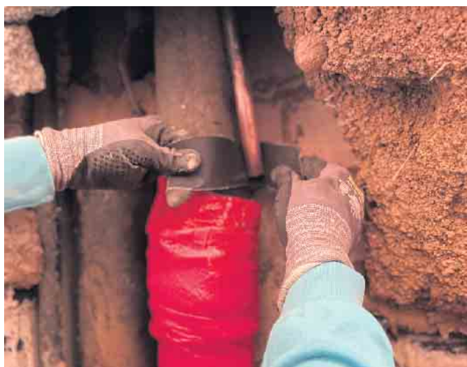
Der Monteur bereitet das vorhandene Kupferrohr auf die neue Verbindung vor. Er reinigt die Verbindungsstelle von Spänen und Schmutz.
