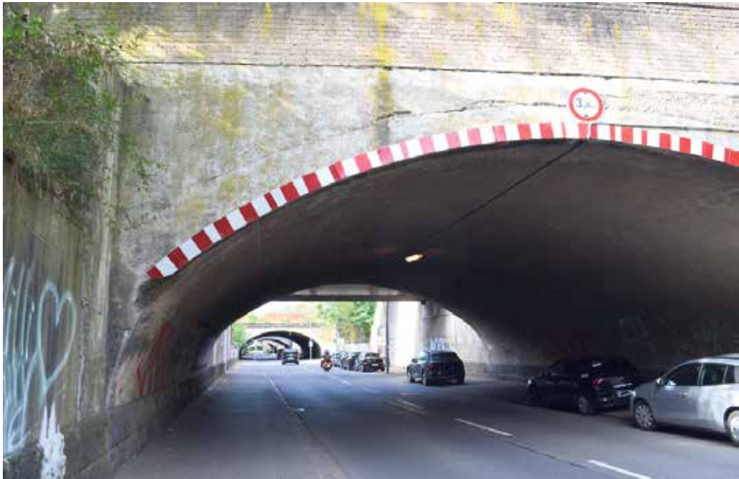
Auf voller Länge unter den Brücken wird die Straße für die Bauarbeiten gesperrt. Foto: Göllnitz
