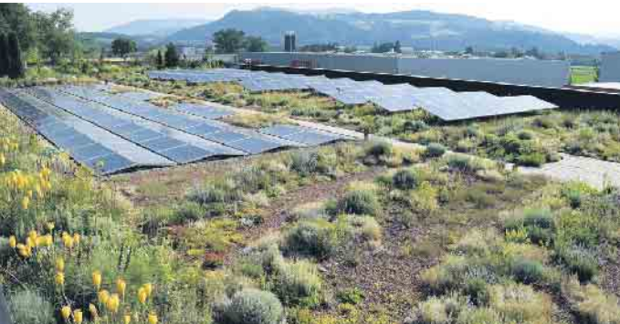
Die perfekte Kombi: Photovoltaik und Gründach. Fotos: Bundesverband GebäudeGrün e.V./akz-o
