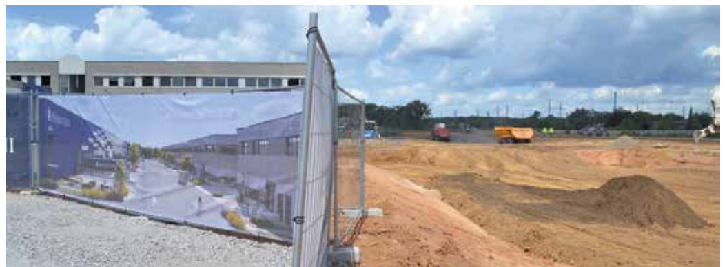
Teile des Areals sind von bisherigen Bauwerken befreit. Eröffnung soll Ende 2027 sein. Foto: Göllnitz
