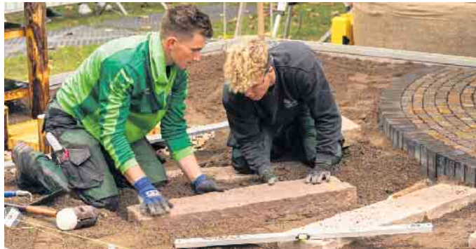
Bei der Verlegung von Trittstufen ist handwerkliches Geschick und Teamarbeit gefragt. Foto: AuGaLa/Reidel
