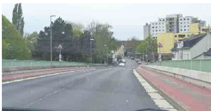
Die Bergerbrücke soll wohl 2028 neu gebaut werden. Die BV möchte, dass zuvor einer der gesperrten Treppenaufgänge wieder geöffnet wird. Foto: Göllnitz
